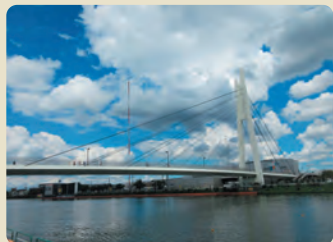
戸田公園大橋
